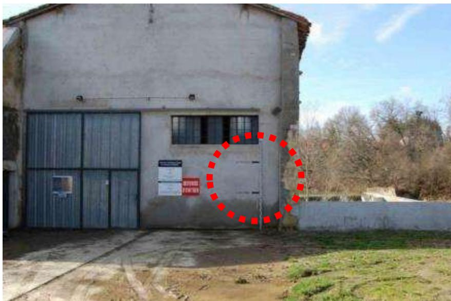
**Figure 8-7 : Centrale hydroélectrique de BELPECH : 3 crues repérées 1875 (2,3 m), 1981 (1,28m) et 2020 (1,03 m, non visible) (photo Geosphair)**
